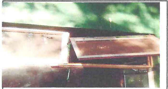
foto. 4: las ventanas por el uso y pesor se arrancaron quedando inviables.
