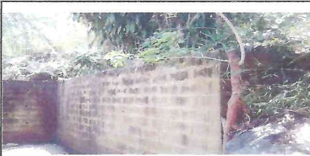
foto 5 . muros necesitan pintura y continuación con la maya para su circulación total
